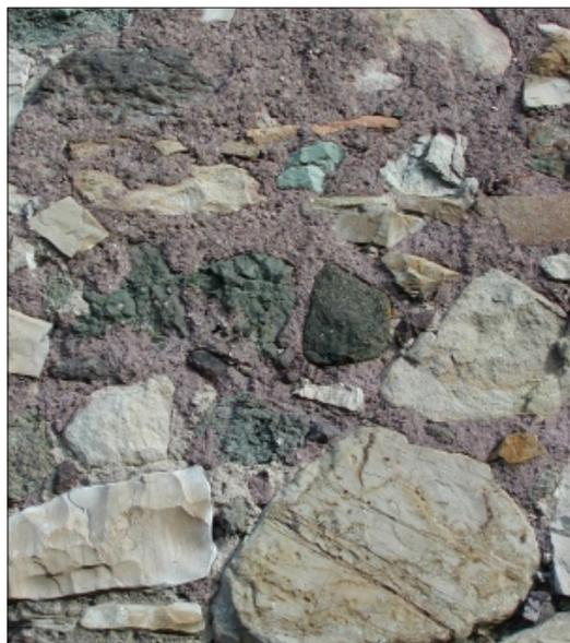
tipologia n°4: stuccatura realizzata con calce di tonalità rossastra per la presenza di elementi inerti ofiolitici. Abbondante stuccatura con parziale ricoprimento delle pietre. Tipologia utilizzabile solo nell’intorno e nel borgo di Rossena.
