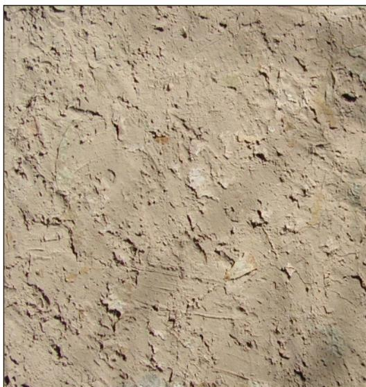
intonaco con superficie irregolare, ottenuta mediante getto diretto della calce e successiva arricciatura.
