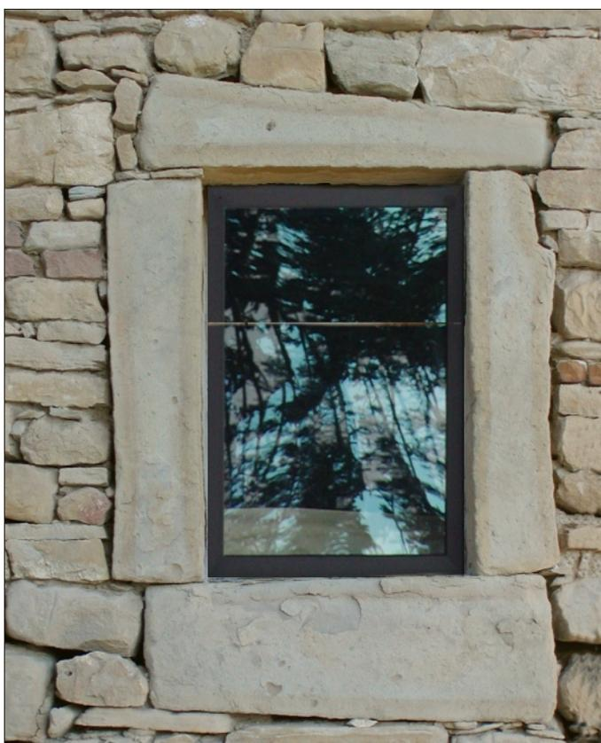
recupero funzionale di una antica finestra, realizzato mediante un telaio vetrato di tonalità scura e di modesto spessore che consente di conservare l'equilibrio estetico-culturale del manufatto.
