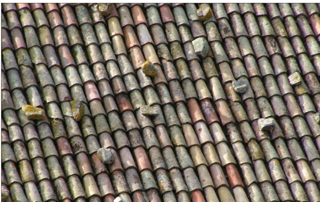
manto di copertura in laterizio (coppi) conforme alle caratteristiche dell'area di tutela paesaggistica di Canossa
