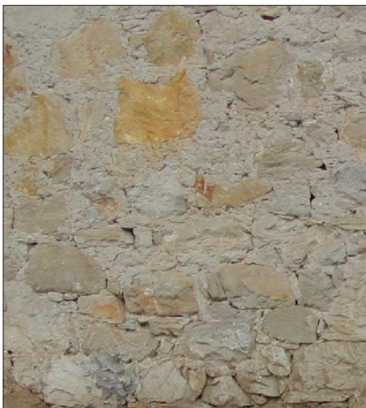
tipologia n°1: stuccatura “a spatola” realizzata con malta a frattazzo, tenuta a superficie ruvida ed irregolare e con ricoprimento degli elementi lapidei.
