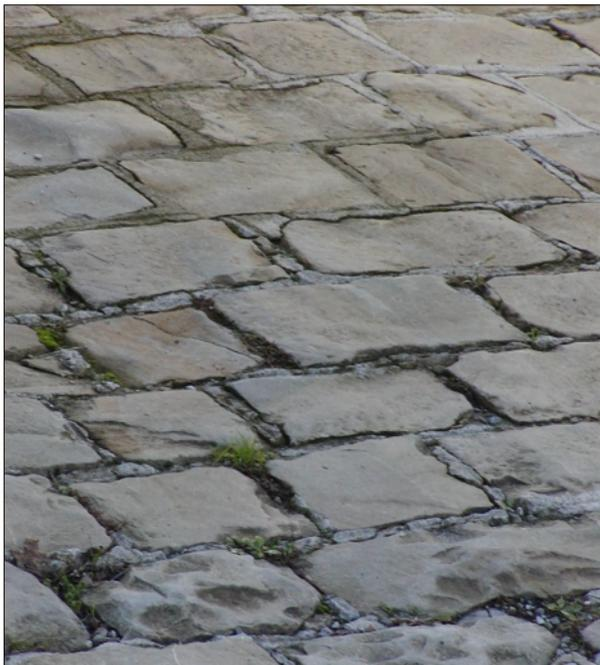
tipologia n°5: elementi quadrangolari di dimensioni eterogenee, a superficie irregolare e scabra a spacco naturale, disposti in corsi paralleli.
