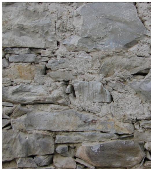
tipologia n°2: stuccatura realizzata con malta a frattazzo tenuta a superficie ruvida e con parziale ricoprimento degli elementi lapidei.
