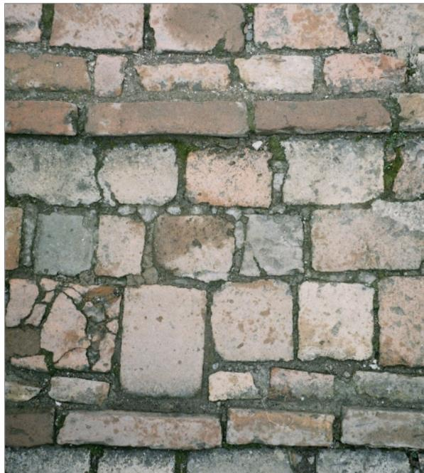
tipologia n°6: pavimentazione mista in pietra e laterizio, con mattoni disposti a coltello che danno origine a gradini di modesta altezza.
