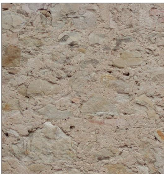
intonaco a superficie irregolare con parziale livellamento degli sbordi di malta e parziale ricopertura degli elementi lapidei.
