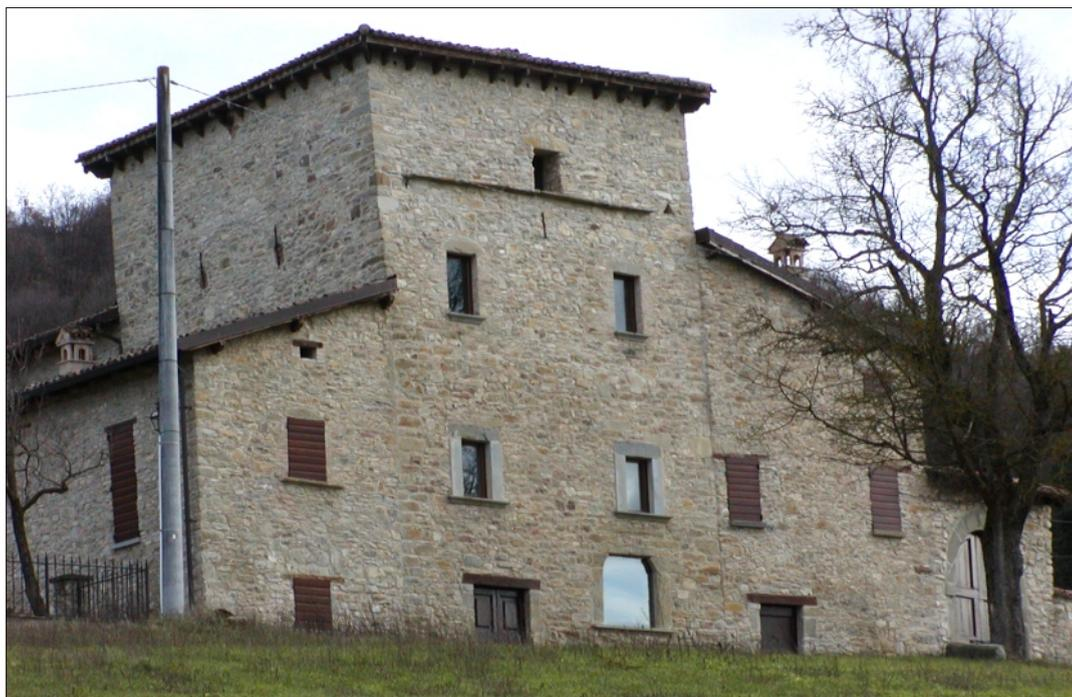
corretto intervento di recupero e sistemazione del prospetto edilizio di un edificio storico con pulitura del paramento e conservazione degli elementi storici di facciata.
