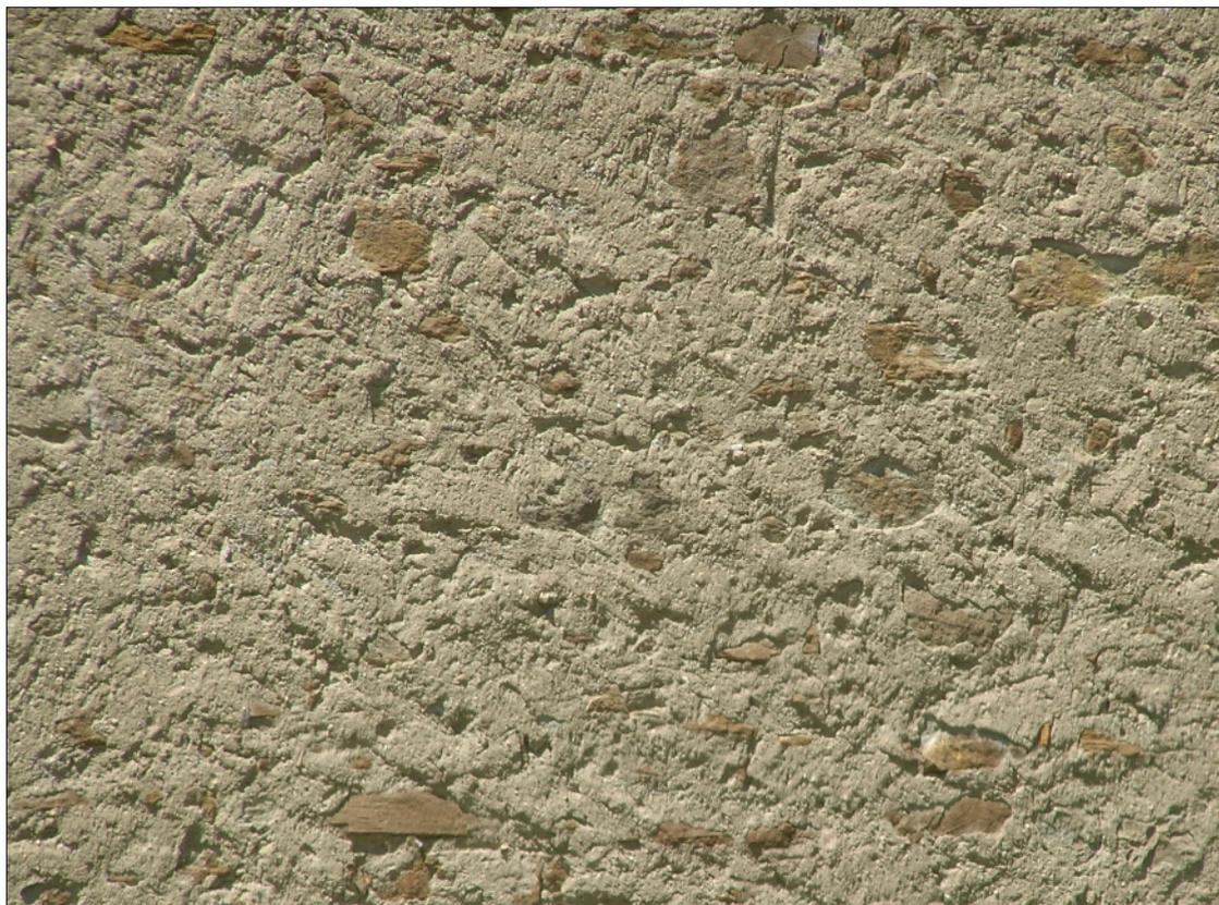
dettaglio dell'intonaco a spatola e frettazzo proponibile per gli interventi da effettuarsi nei fabbricati di vecchia e nuova costruzione, in presenza di muratura in pietra.
