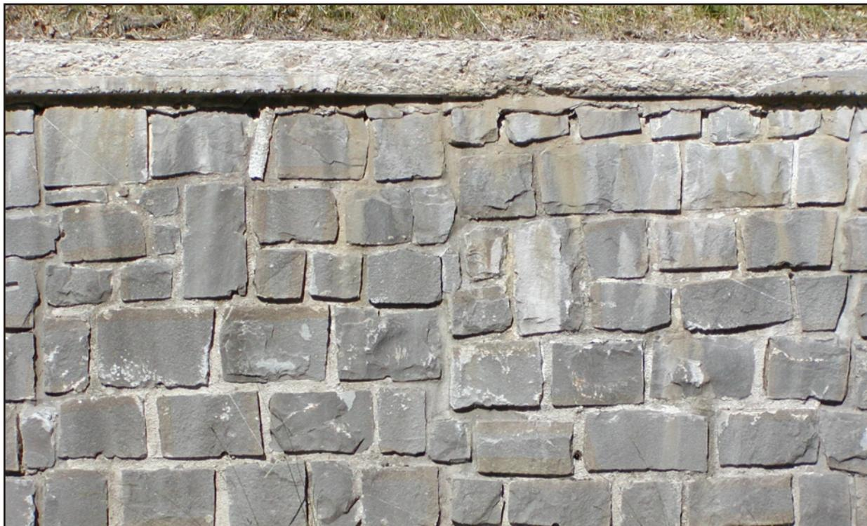
Tessitura scorretta: muro stradale realizzato con tessitura a conci eccessivamente squadrati e regolarizzati che determina un forte impatto percettivo
