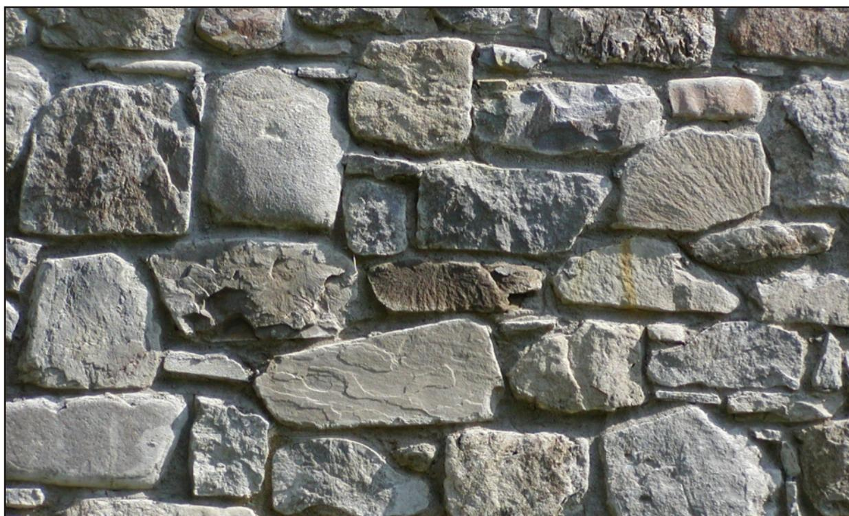
Tessitura corretta: muro stradale realizzato con corretta tessitura del paramento
