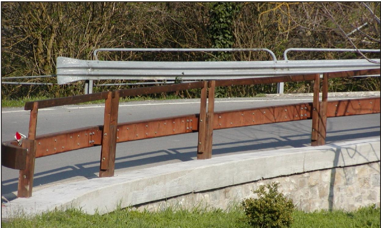
Comparazione tra una protezione stradale di tipo tradizionale (metallica) ad elevata percettibilità ed un analogo manufatto in legno rinforzato
